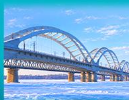
สะพานรถไฟโปนโจว
